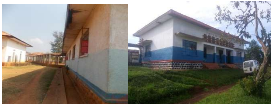
HGR Fizi avant et après la réhabilitation grâce au Bonus d'investissement
